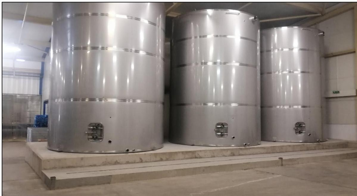
Obr. 8 Osadenie nových akumulačných nádrží
