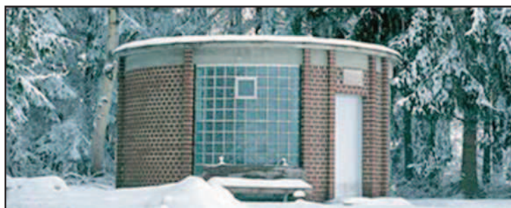
Obr.2 Zemní vodojem v obci Sauldorf zásobuje pět čerpacích stanic a tři vodojemy celkovým množstvím cca 6,5 \text{ l.s}^{-1}
