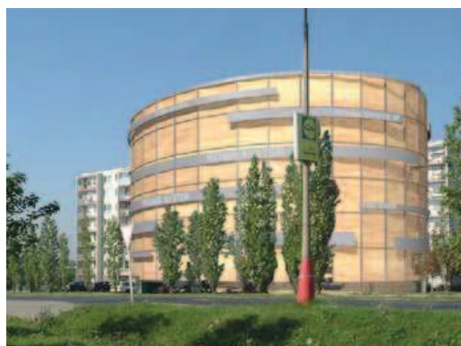
Obr. 9 – Ukázka parkovacího domu Zdroj:
